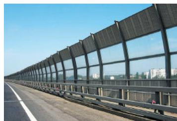
**Рис. 6.** Шумозащитные экраны, установленные около трасс, уменьшают уровень шума в несколько раз
