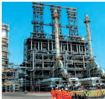
Рис. 43.7. Колонна крекинга нефти на Одесском нефтеперерабатывающем заводе
