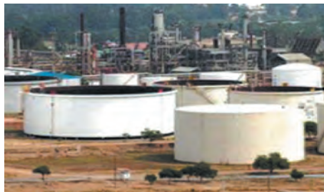
Рис. 43.4. Нефтяные резервуары Лисичанского нефтеперерабатывающего завода
