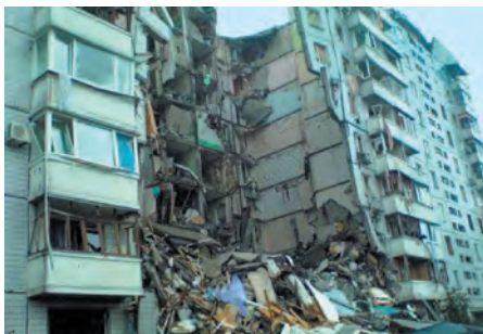
Рис. 23.5. Последствия взрыва природного газа в многоэтажном жилом доме, 13 октября 2007, г. Днепр
