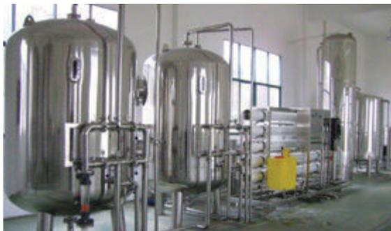
**Рис. 116.** Водоочистительная станция, на которой речную воду готовят к подаче в водопроводную сеть
