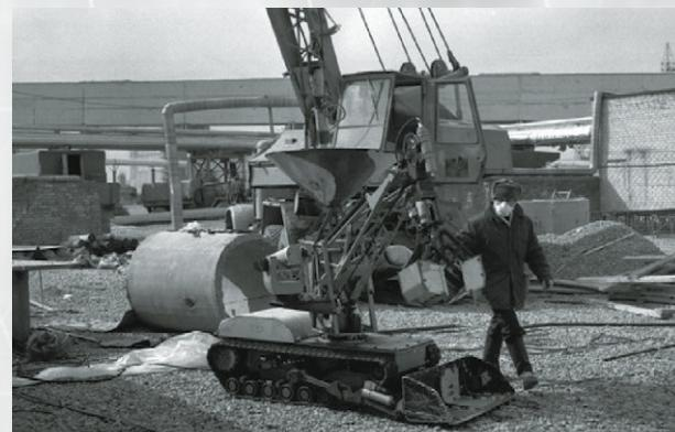
Утім, більшість роботів виявилися непридатними для роботи в умовах ЧАЕС. Наприклад, радіокерований бульдозер-амфібія «Komatsu», який міг працювати навіть на морському дні, не витримав радіаційних навантажень і швидко вийшов із ладу. Непридатними для роботи в жорстких радіаційних умовах виявилися і два німецьких роботи MF-2 і MF-3.
