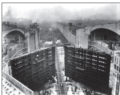
Будівництво Панамського каналу. Початок XX ст.
