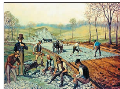
Прокладання першої дороги із щебеню в США в 1823 р.
